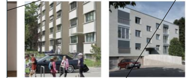
Bau des Monats 08/2022 Hirzenbach
