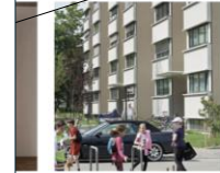
Bau des Monats 08/2022 Hirzenbach
