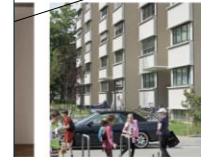
Bau des Monats 08/2022 Hirzenbach
