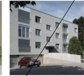
Bau des Monats 07/2022 Eichweid
